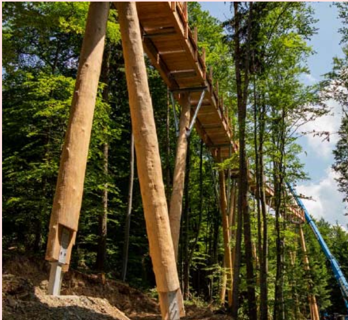
ABBILDUNG 4: KONSTRUKTION DER STÜTZTRÄGER
