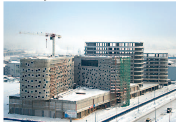
AIRPORT CITY ST. PETERSBURG St. Petersburg/Russland, Baustelle
