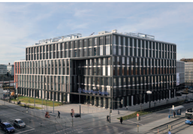
ARNULFPARK® München / Deutschland, Bürogebäude ATMOS, im Hinblick auf Nachhaltigkeit zertifiziert
