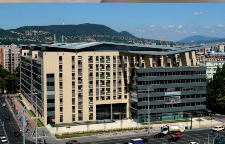
BÜROGEBÄUDE CAPITAL SQUARE, BUDAPEST Ausgezeichnet als „Beste Büroentwicklung 2009“ (Construction & Investment Journal-Award)
