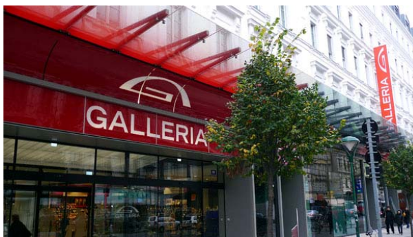
WIEN, Einkaufszentrum Galleria
