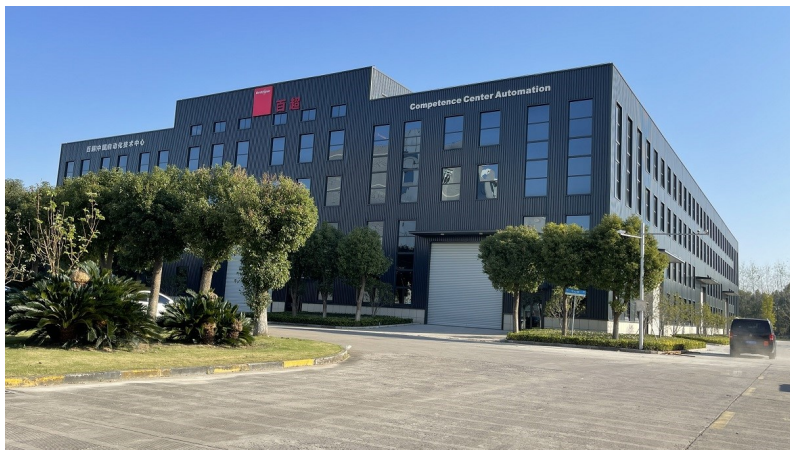
Das neue Competence Center Automation in Shanghai (China) für Automationslösungen.
