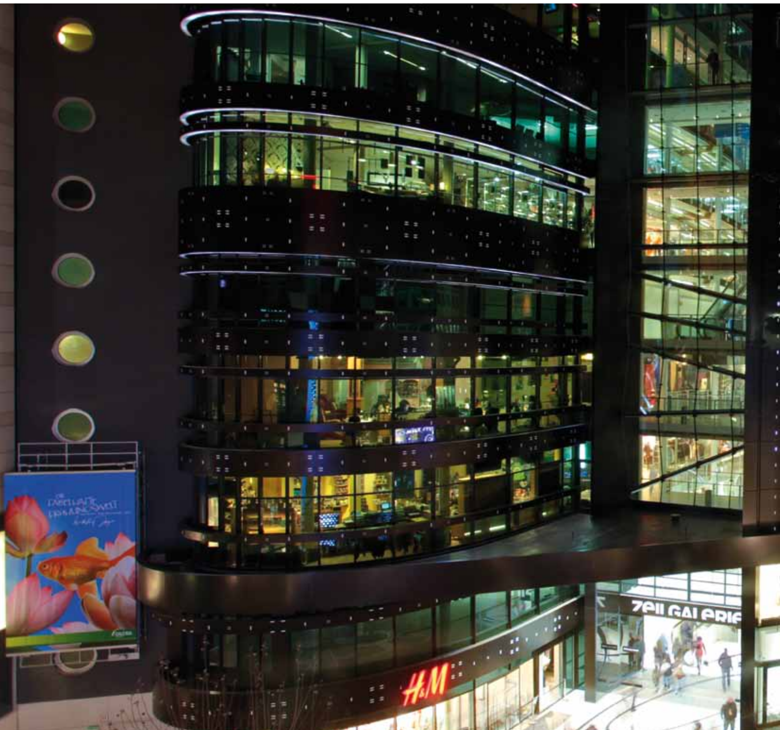
Zeilgalerie, Frankfurt am Main
