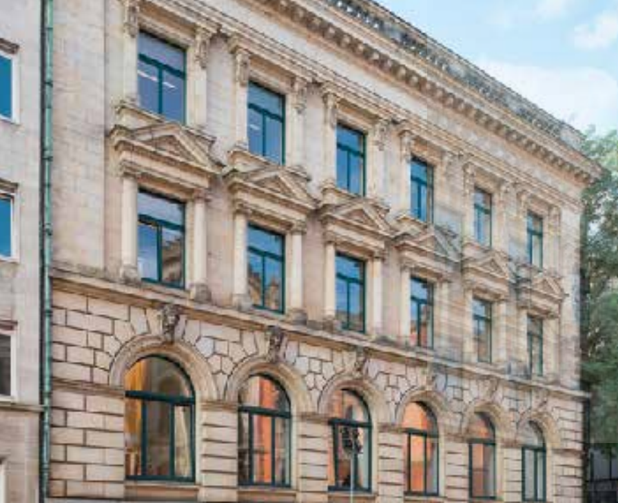
Hanover | Landschaftstrasse 8 Office Building
