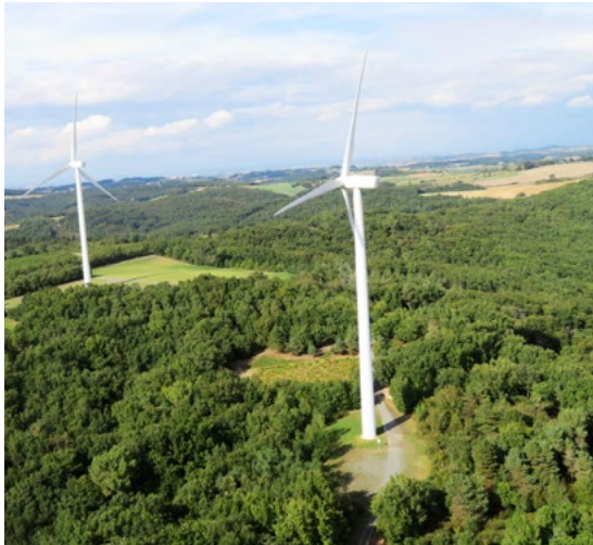
Windpark Cuq in Frankreich
