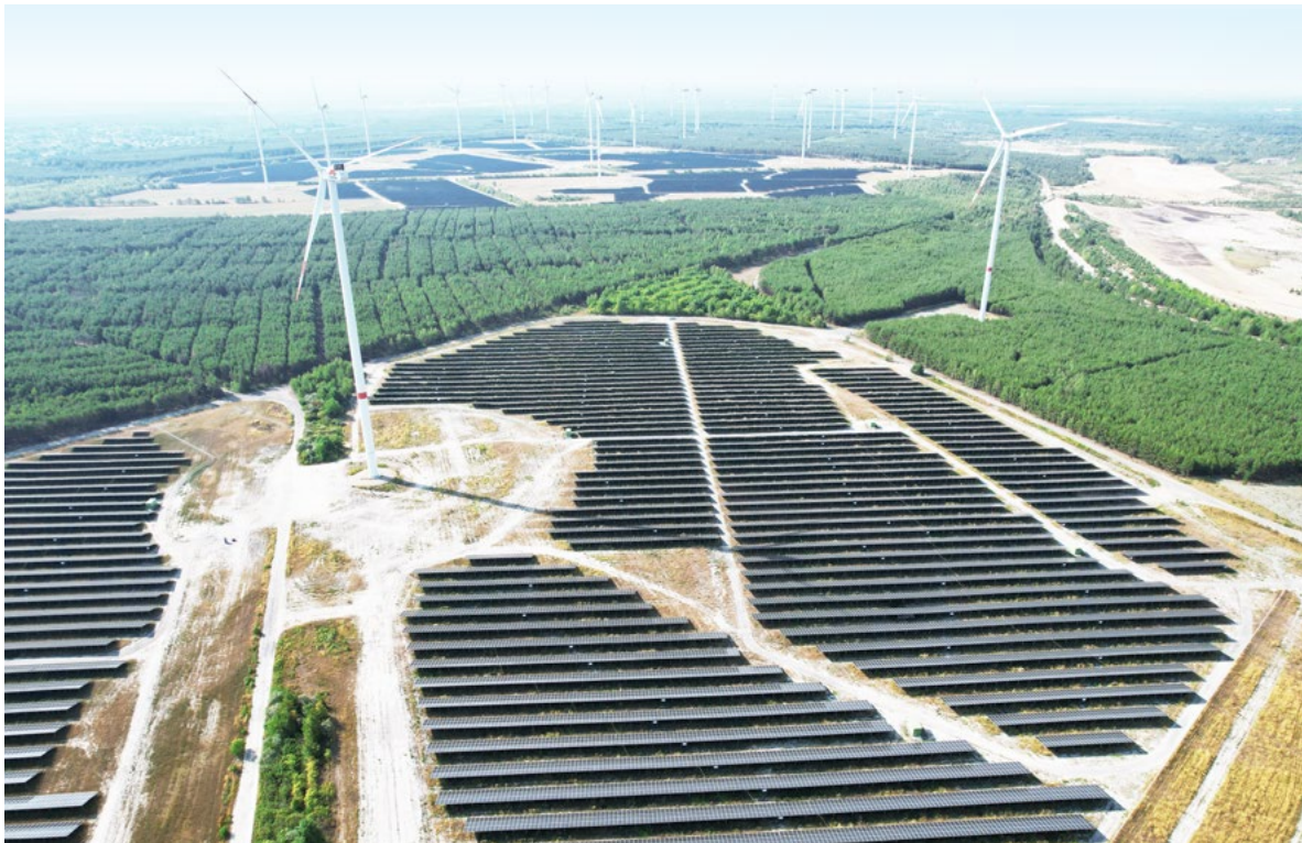
Solarpark Klettwitz Nord in Deutschland
