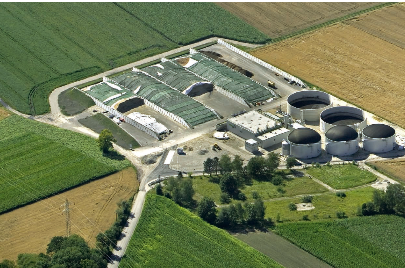
Luftbild der Biomethananlage Pliening
