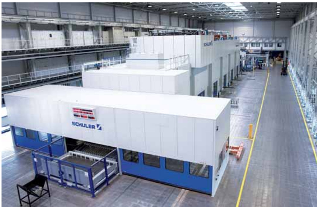
Hydraulische Pressenlinie mit Platinenlader (im Vordergrund) und Roboterautomation
