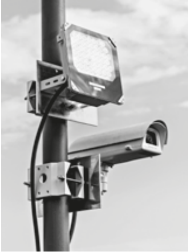
RailWatch-Kamera zur Identifizierung des vorbeifahrenden Wagens
